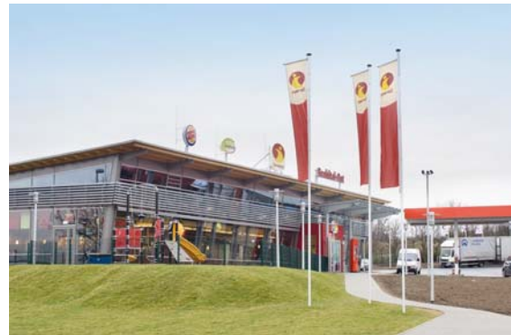
(Abb.: Tank und Rast in Brohital-Ost)
