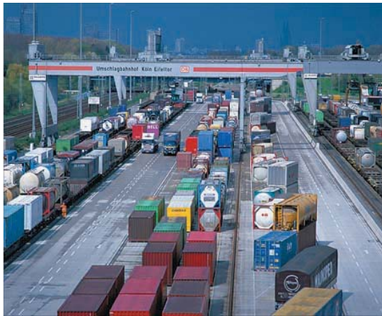
(Abb.: Umschlagbahnhof Köln Eifeltor)
